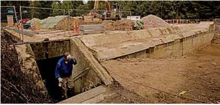
Bunkeren blev under ombygningen til arkiv fritlagt for at der kunne lægges dræn rundt om den. Foto: COWI
