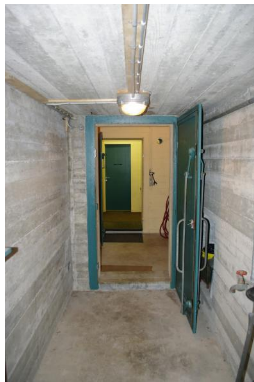
Foto til venstre: For at lede trykbølgen fra en eksplosion forbi indgangsdøren har indgangspartiet en "blindtarm". Døren ind til bunkeren er i væggen på højre side.
