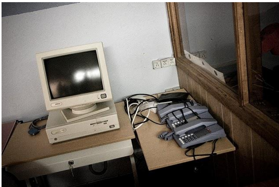
Den teknologiske udvikling løber så stærkt, at udflytningsanlæg meget hurtigt forældes. Derfor er det f.eks. en sjældenhed at se PC'er i bunkere som her. Der findes også kun én. Foto: Anders Kvist 2011.
