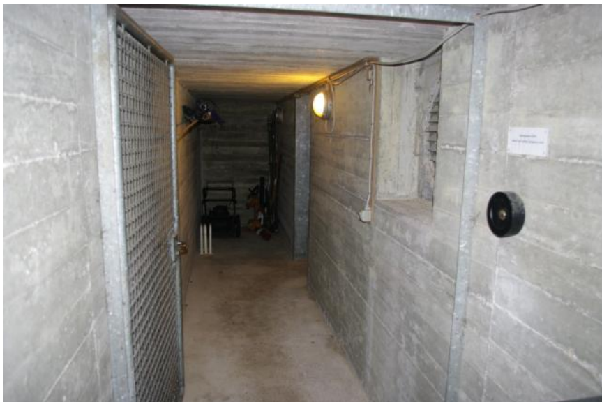
Foto til venstre: For at lede trykbølgen fra en eksplosion forbi indgangsdøren har indgangspartiet en "blindtarm". Døren ind til bunkeren er i væggen på højre side.
