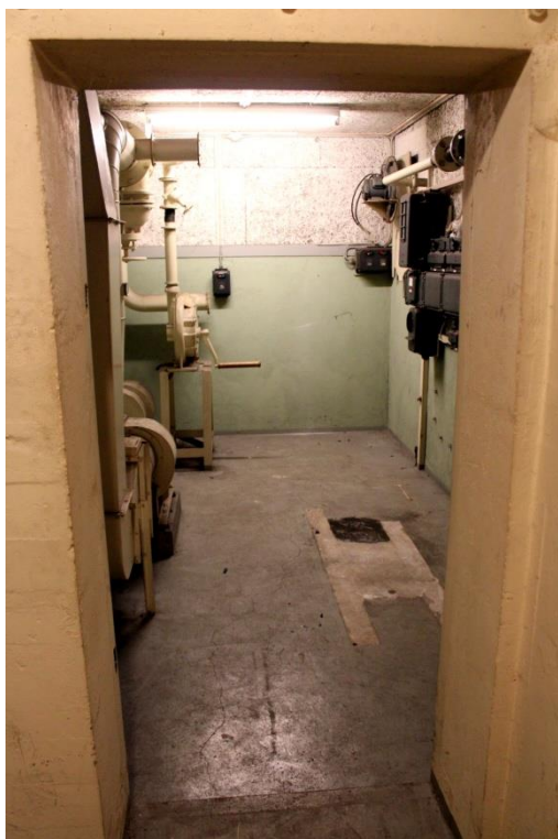
Foto til venstre: 42kW generator blev fjernet da KC'en blev nedlagt. Den var meget tung og svær at få op, men den var relativ ny og kunne derfor genbruges. Til venstre ses ventilationsanlægget.
