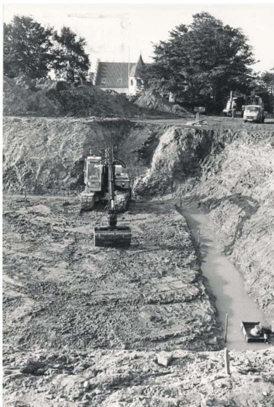
Der graves ud til bunkeren. Foto: Finn Folsted 1980
