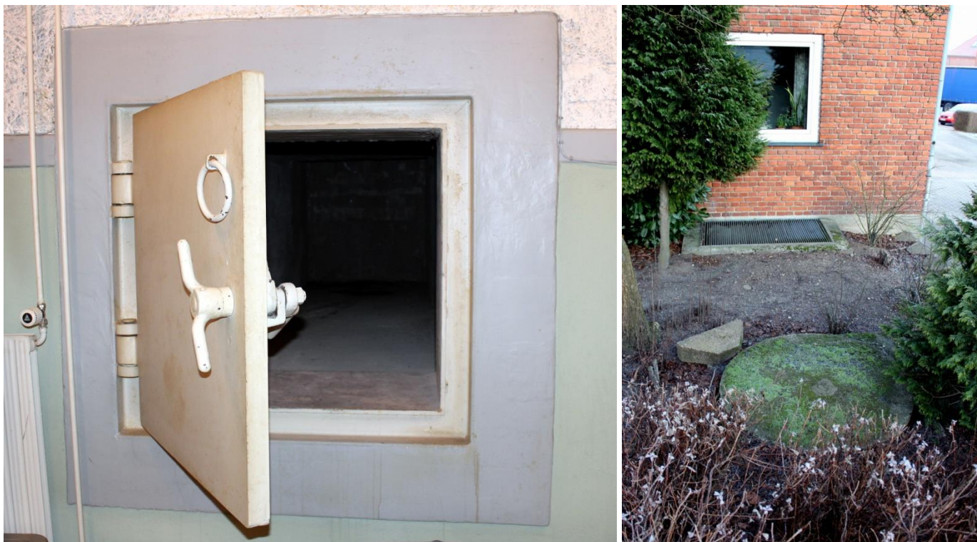
Nødudgang, der fører op til betondækslet. Foto: Karsten Pedersen 2012.
