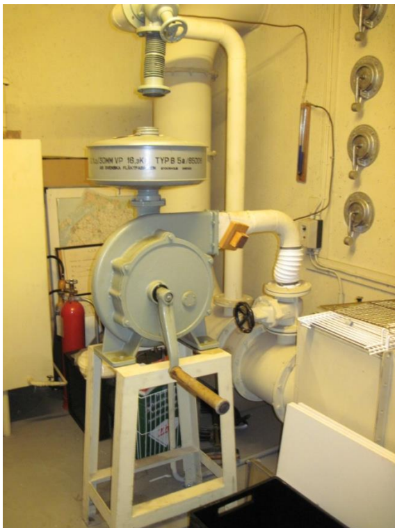
Ventilationsanlægget samt overtryksventiler. Foto: Ib Friis 2012.
