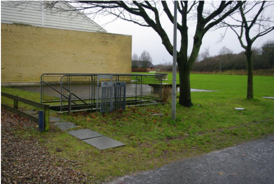
Indgangen til bunkeren. Nøddgangen ses ude på græsset. Foto: Martin Pagh, Jysk Koldkrigsforening, 2014
