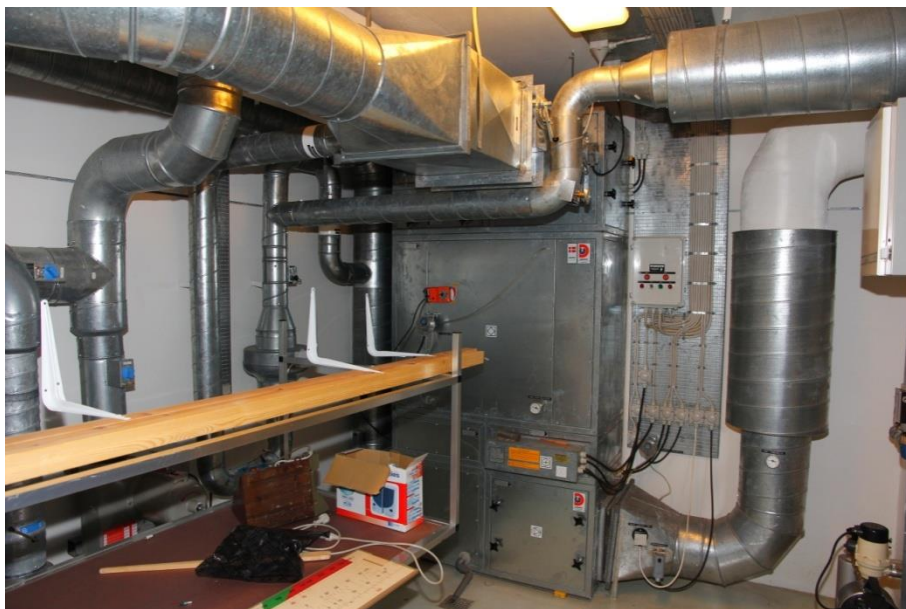
Ventilationsalægget. Foto: Peter Rask 2011.
