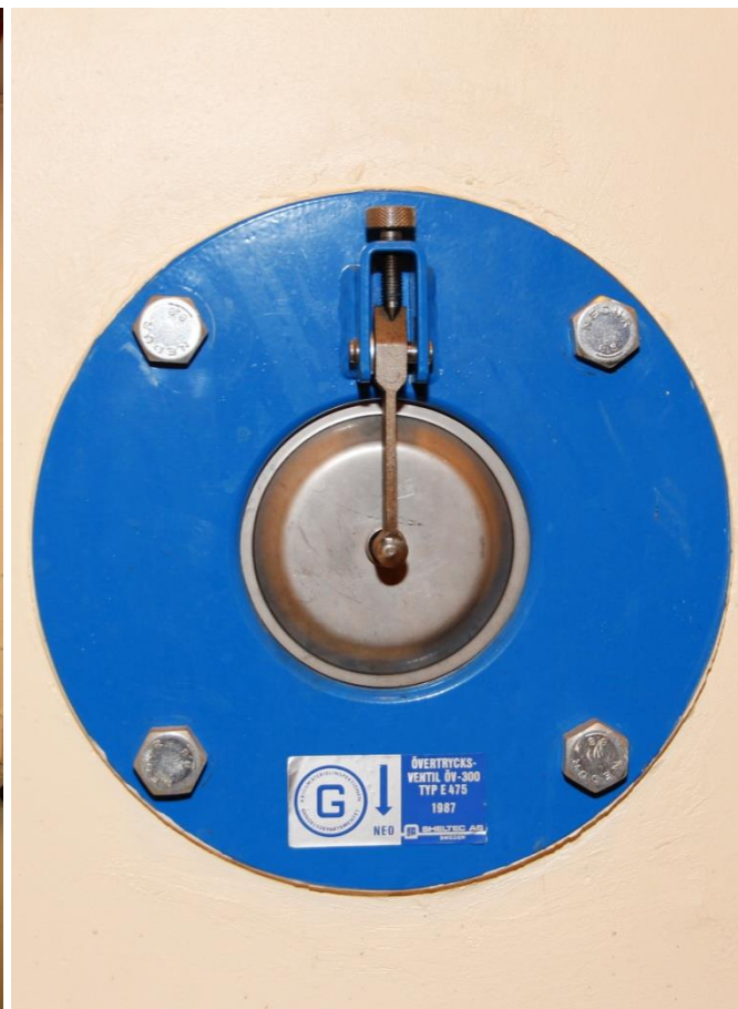
Foto til højre: En af flere overtryksventiler. Det ses af klistermærket, at den svenske krigsmateriel har godkendt ("G") eksporten af overtryksventilen.
