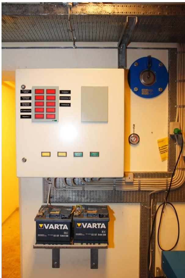
Fejlmelde-tavle incl. batteri back-up. Til højre set et udklip af, hvad der står på tavlen. Foto: Peter Rask 2011.
