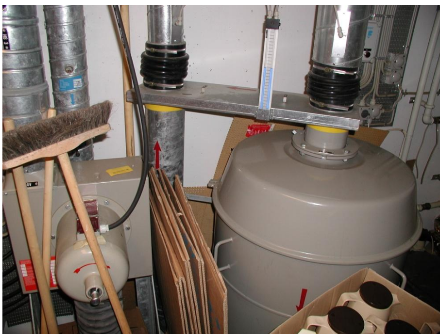
Ventilationsrummet. Foto: Henrik Pedersen 2011.
