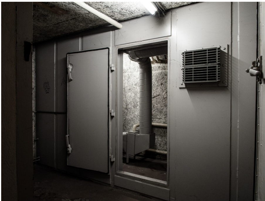
Ventilationsrummet. Indsugning sker via ind en kanal, der går op over skolens tag. Foto: Jakob Færch-Jensen 2013.
