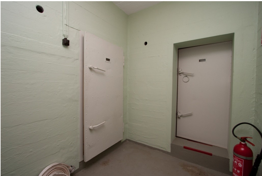
Gasslusen. Døren til højre fører ind til ventilationsanlægget og døren til venstre ind til entreen i selve KC'en. Foto Michael Bødstrup Hansen 2011.
