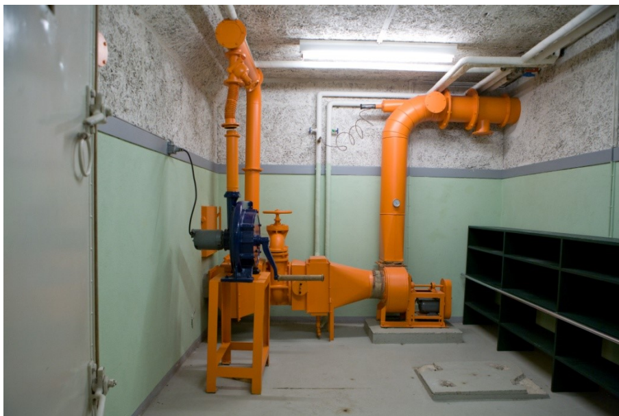
Foto til venstre: Ventilationsanlægget er – som det eneste sted hidtil set – malet i civilforsvarsstyrelsens (nu kaldet Beredskabsstyrelsens) farver – orange og blå. Det blå aggregat er et reserveventilationssystem, som betjenes med håndkraft. På gulvet ses en sokkel hvorfra noget er fjernet. Der er tilsyneladende tale om en sokkel til en nødgenerator, som senere er flyttet uden for bunkeren af hensyn til indeklimaet.
