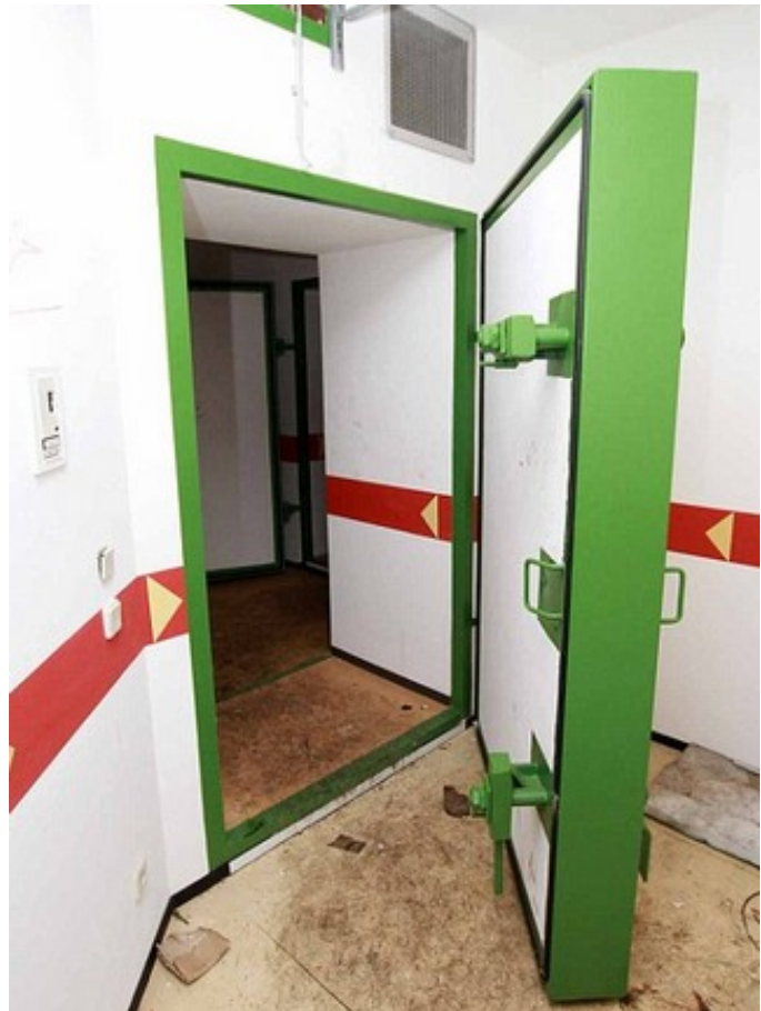
Betondøren i indgangspartiet (Foto: Martin Pagh, Jysk Koldkrigsforening, 2014). Producenten er Luwa fra Schweiz, der bl.a. også har leveret døre til den libyske diktator Gaddafis private bunker uden for Al-Baida (foto til højre). Den samme dør findes i Rudkøbing KC.
