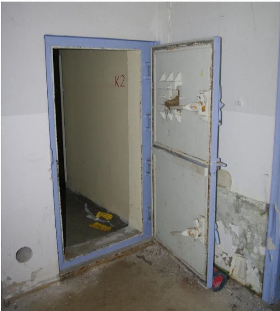
Indgangen. Begge døre er fra en tyskbygget bunker, som Civilforsvarsstyrelsen fik en del af dørene efter krigen. Den tykke er en type 434P01 "stalddør" 30 mm tyk og med en vægt på 640 kg. incl ramme. Derudover er der en tyndere dør "gasdør". Der er således en gastæt sluse imellem de to døre. Foto: Martin Pagh, Jysk Koldkrigsforening, 2014
