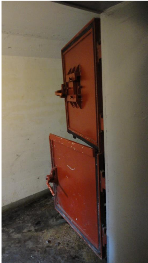
Nedgangen til bunkeren (foto til venstre). Nedgangen fortsætter op igen i modsatte side, så en trykbølge uhindret kan passere. Indgangen er i tunnelens højre side, der her ses indefra (foto til højre). "Stalddøren" vejer 640 kg. og stammer oprindeligt fra en af de bunkere, der blev bygget af tyskerne under 2. verdenskrig. Foto: Poul Holt Pedersen 2011.
