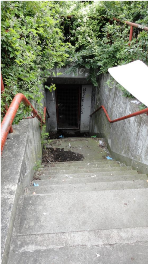
Nedgangen til bunkeren (foto til venstre). Nedgangen fortsætter op igen i modsatte side, så en trykbølge uhindret kan passere. Indgangen er i tunnelens højre side, der her ses indefra (foto til højre). "Stalddøren" vejer 640 kg. og stammer oprindeligt fra en af de bunkere, der blev bygget af tyskerne under 2. verdenskrig. Foto: Poul Holt Pedersen 2011.
