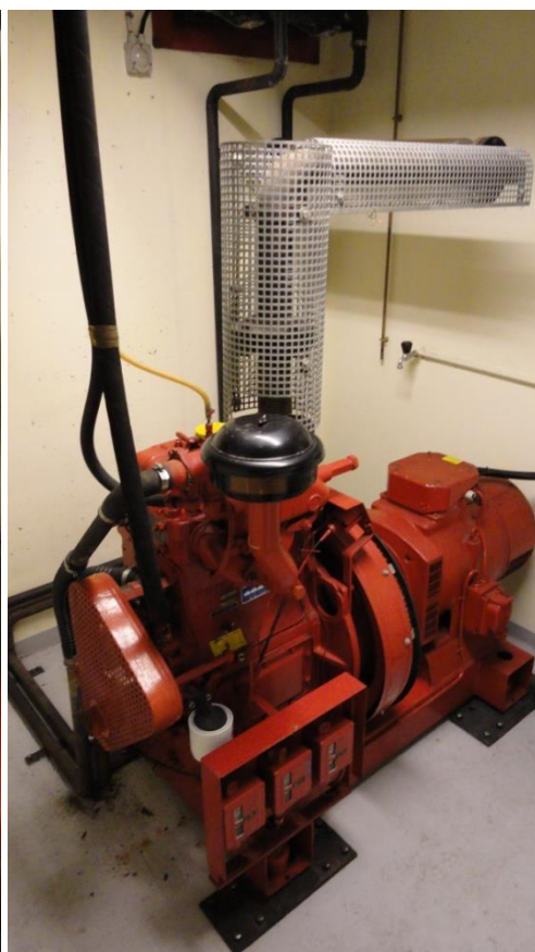
Gasfilter og BUKH 2 G 105 dieselmotor med påmonteret DAE G 400.430 generator. Foto: Poul Holt Pedersen 2011.
