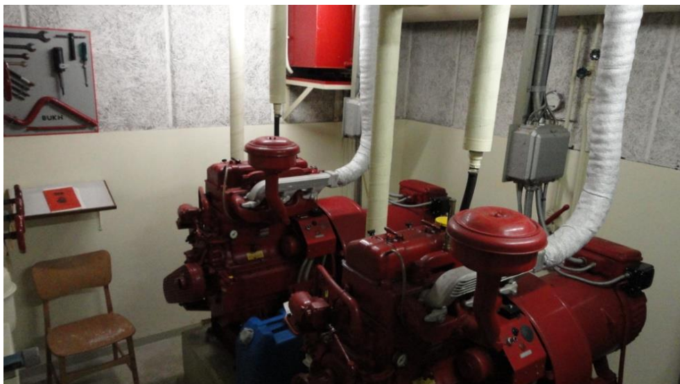
Normalt har de kommunale KC'ere kun en nødgenerator. Men fordi Amager bunkeren er så stor har den to. Derved er der også ekstra sikkerhed for, at mindst én af dem virker, hvis strømmen fra bynettet går. Foto: Poul Holt Pedersen 2011.
