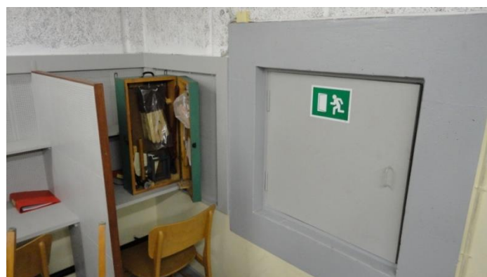
Udbrydningsværkøj og nødudgang. Foto: Poul Holt Pedersen 2011.
