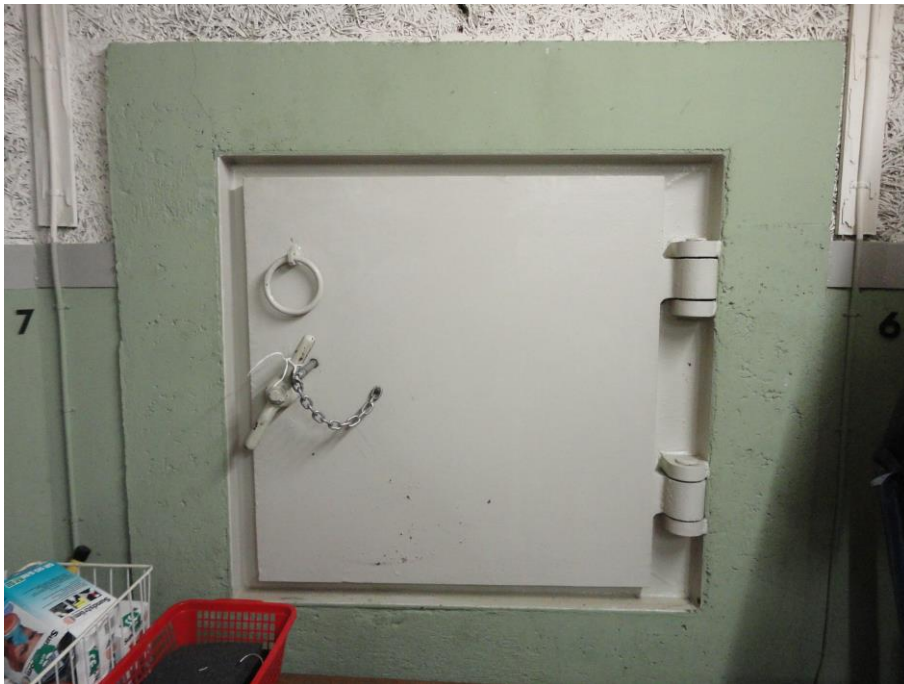
Nødudgangen fører op i skolen. Nødudgangene skulle normalt føres et stykke væk fra bygningen, så det var muligt at undslippe fra bunkeren, hvis bygningen ovenfor styrtede sammen. Birkerød KC ville derfor være en potentiel dødsfælde i tilfælde af bombing af byen. Foto: Poul Holt Pedersen 2013.
