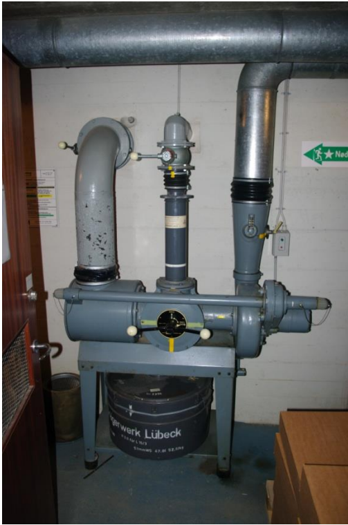
Ventilationsanlæg. Foto: Martin Pagh 2013.
