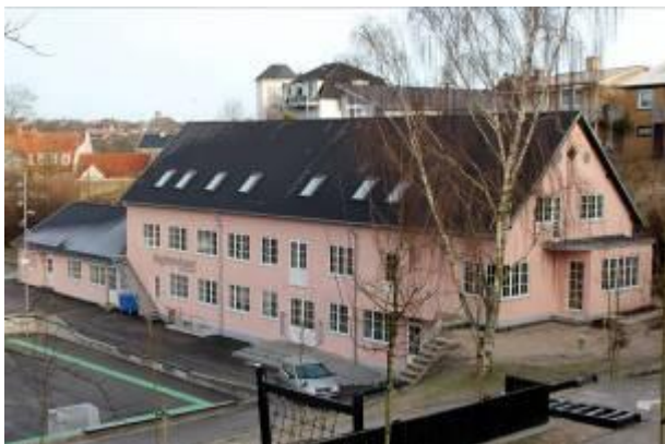
Den tidligere Hobro civilforsvarskaserne, som den ser ud i dag.
